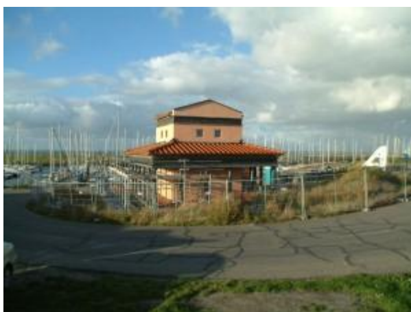
Foto van de Tempel Nehalennia in aanbouw.
